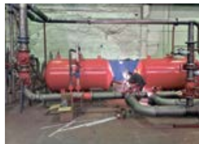
Процесс сборки трубопроводной обвязки
