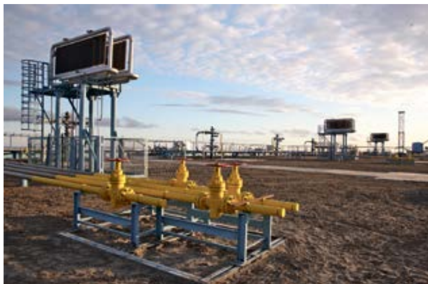
Рис. 2. Куст газовых скважин с установками стабилизации в летнее время
