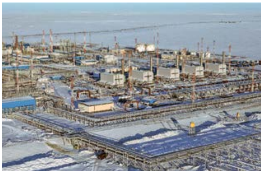
Рис. 5. Газовый промысел № 2 Бованенковского НГКМ
