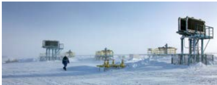
Рис. 1. Куст газовых скважин с установками термостабилизации грунтов в зимнее время
