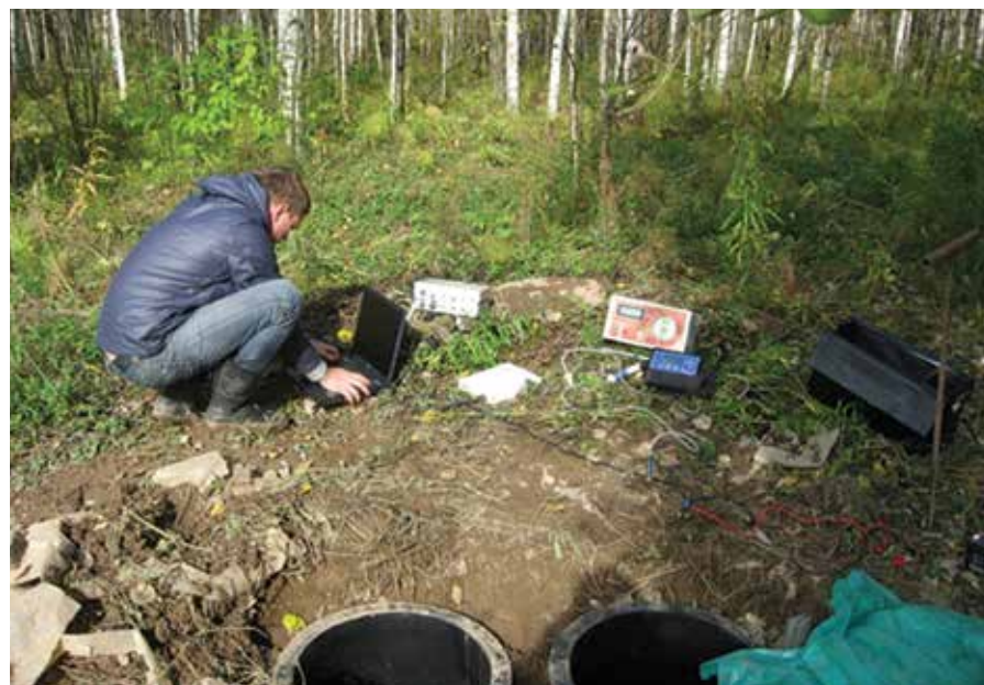
Фото 3. Монтаж автоматизированного газово-эманационного прибора на контрольном пункте сети мониторинга
