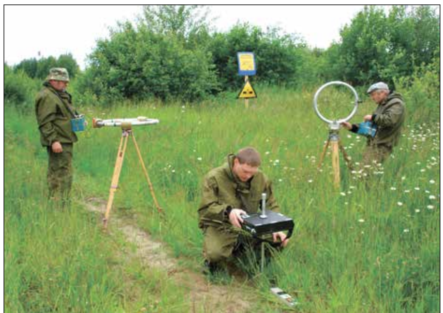
Фото 1. Радиоволновой комплекс обследования грунтов трассы газопровода
