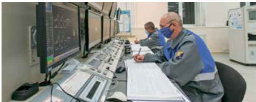
В диспетчерской филиала ООО «Газпром ПХГ» «Канчуринское управление подземного хранения газа»
