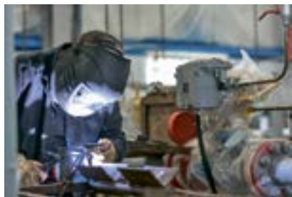
Строительство сборного пункта газа № 1
