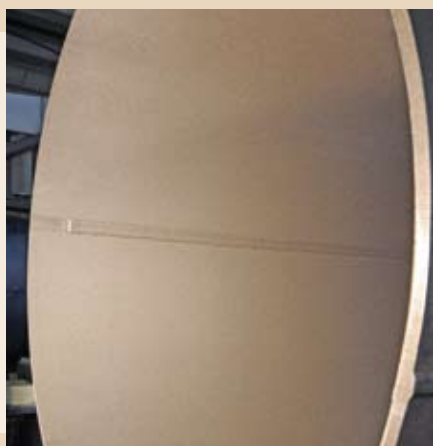
Рис. 4. Внутренняя поверхность трубы после обработки дробеметом
