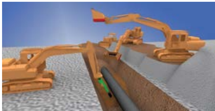
Рис. 5. Навесные устройства к стреле экскаватора для засыпки трубопровода Fig. 5. Hitch attachments to the excavator arm for the pipeline burial
