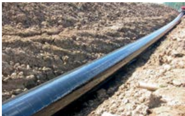
Рис. 4. Уложенный в траншею трубопровод Fig. 4. The pipeline laid in a trench
