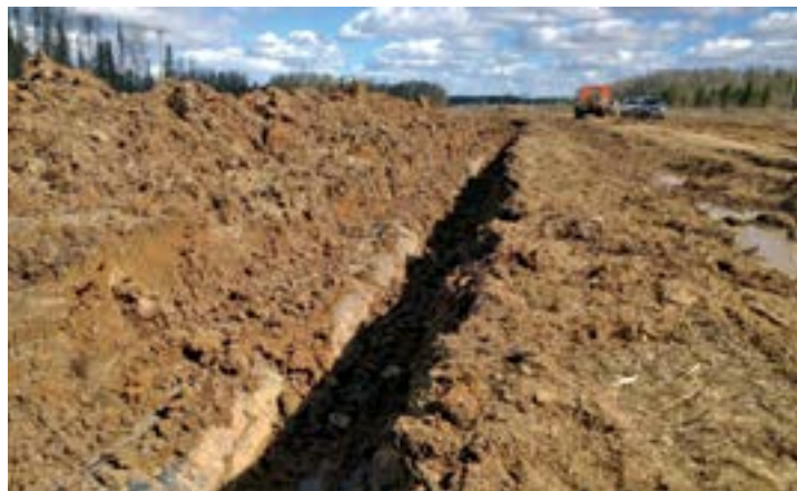
Рис. 2. Разработка траншеи с одной стороны трубопровода Fig. 2. Trenching on one side of the pipeline
