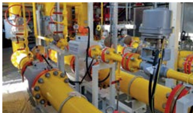
Фото 4. Измерительные линии узла коммерческого учета газа
