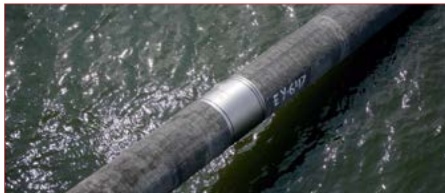
Рис. 2. Вид трубы при прокладке подводной части газопровода с баржи
