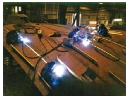
Рис. 8. Комплекс Kemppi – Railtrac 1000 при сварке листовых конструкций в нижнем положении
