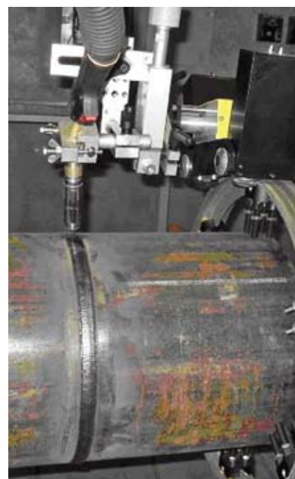
Рис. 3. Сварочная головка Railtrac Orbital Wпри сварке труб
