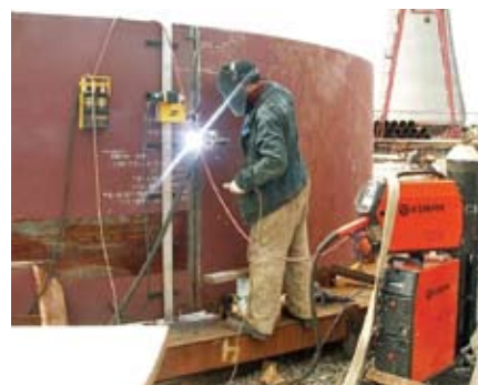
Рис. 7. Сварка комплексом Kemppi – Railtrac 1000 дымовой трубы диаметром 8 м и высотой 80 м
