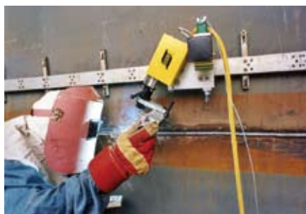
Рис. 6. Сварка горизонтального стыка резервуара комплексом Kemppi – Railtrac 1000
