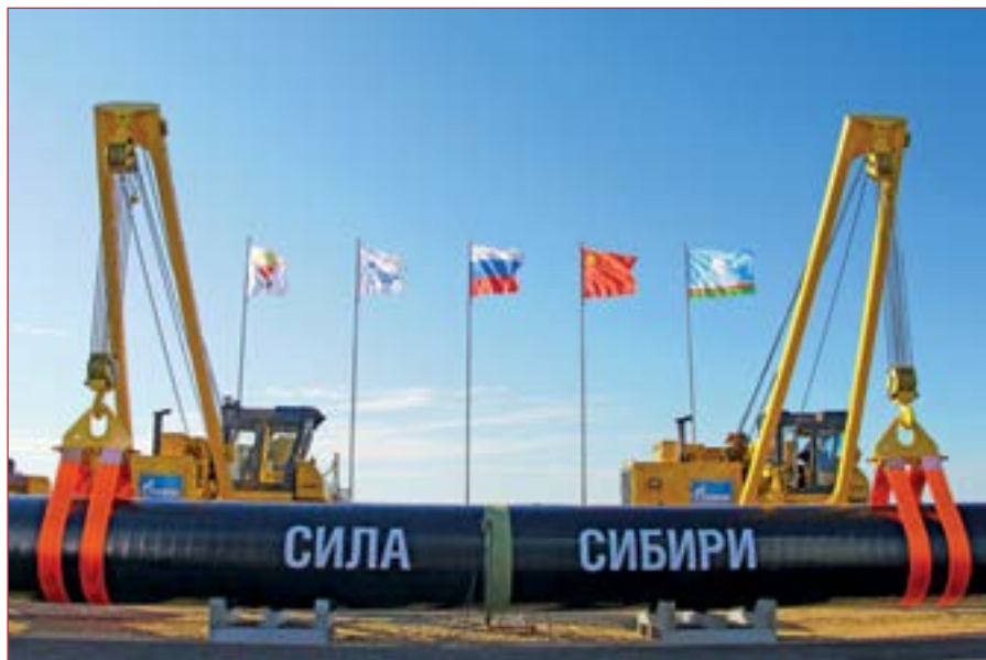
Рис. 2. Газопровод «Сила Сибири», запуск которого запланирован на 2019 г., будет оснащен самыми современными средствами противокоррозионной защиты
