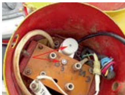
Рис. 2. Корректор и измерительная клемма электрода СЭС-2ЭХЗ
