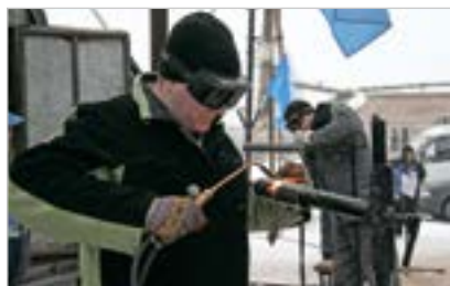
Выполнение пробного стыка трубопроводов на полигоне
