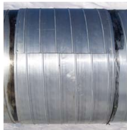
Рис. 4. Защита сварного стыка на теплоизолированном участке нефтепровода «Ванкор – Пурпе»
