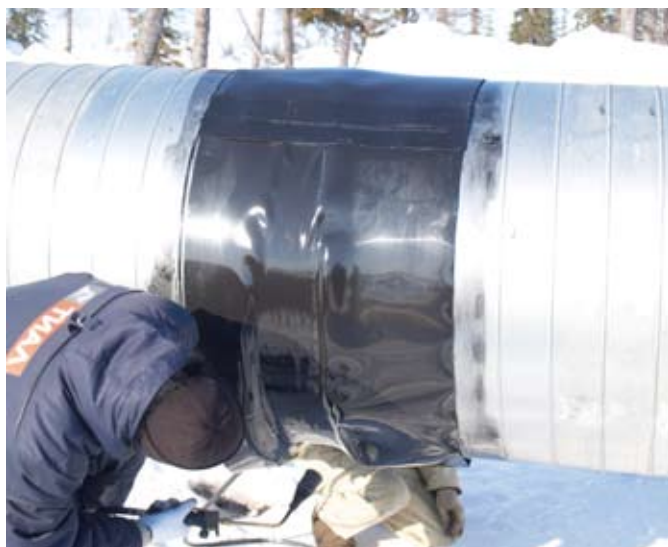
Рис. 6. Гидроизоляция теплоизоляционного слоя
