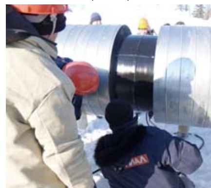
Рис. 5. Нанесение антикоррозионной манжеты ТИАЛ-М80
