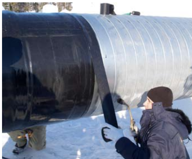
Рис. 7. Нанесение адгезивных лент ТИАЛ-3
