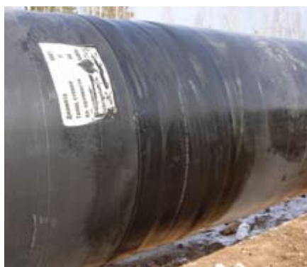
Рис. 3. Сварной стык, изолированный манжетой ТИАЛ-М (проект ВСТО)
