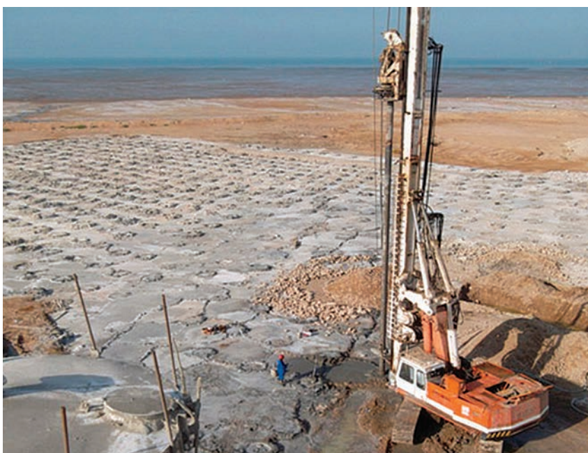
Рис. 2. Устройство основания из грунтоцементных свай при строительстве резервуарного парка в порту Bandar Abbas, Иран. Фото: www.omranista.com
