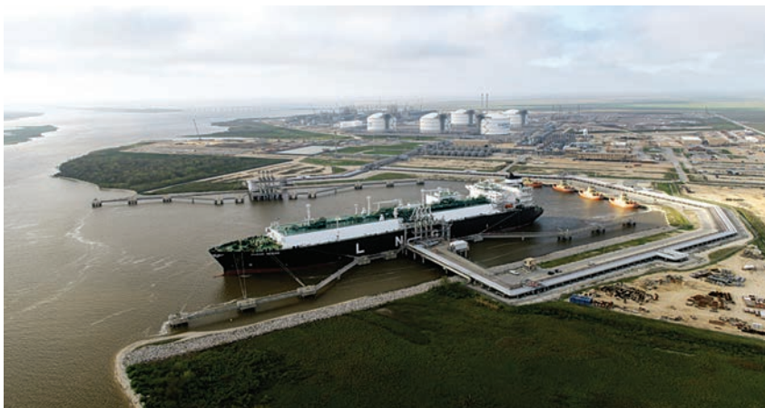
Рис. 1. Завод и отгрузочный терминал СПГ Sabine Pass, общий вид. Фото: www.cheniere.com
