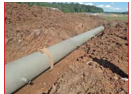
Капитальный ремонт КФЗУ МГ «Уренгой – Новопсков» 1843,6 км
