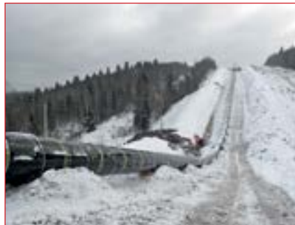
Капитальный ремонт участка МГ «Уренгой – Петровск» 1834-1842 км
