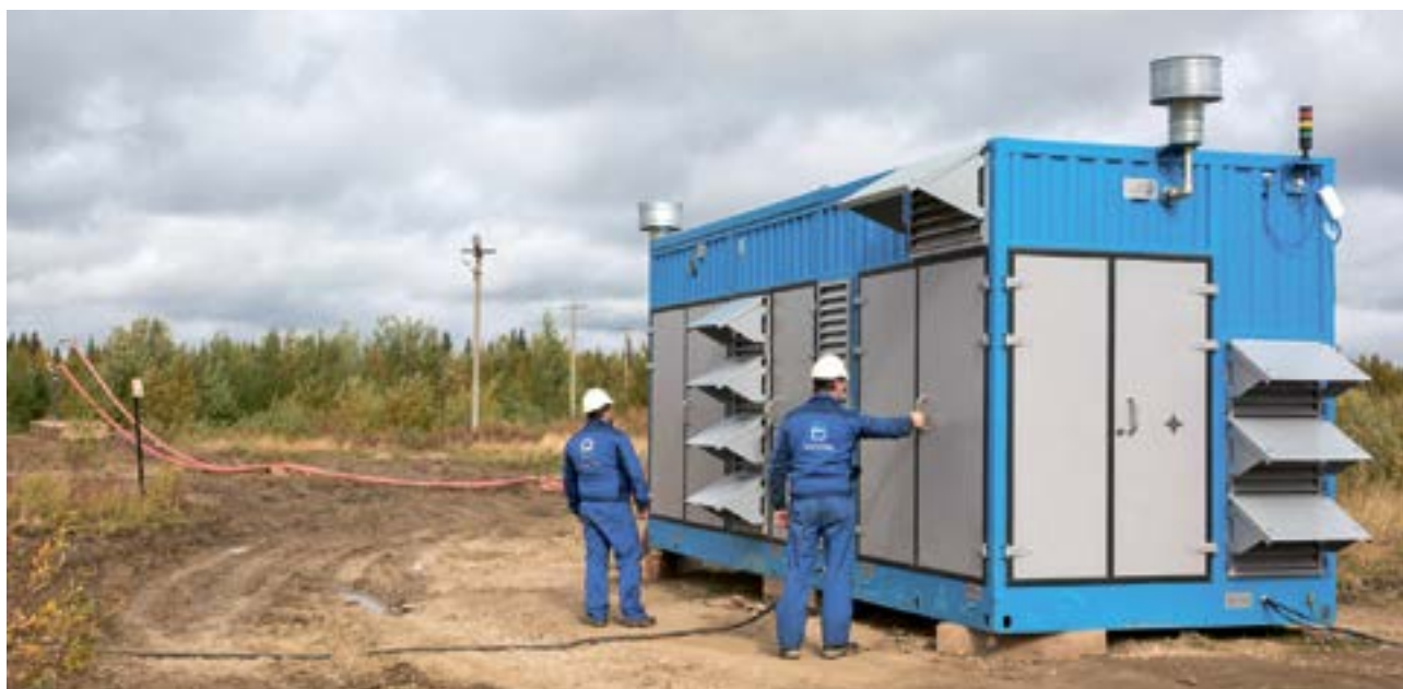
Температура точки росы, измеренная непосредственно внутри трубопровода, составила –41 °С и оказалась значительно лучше требований нормативной документации ПАО «Газпром»
