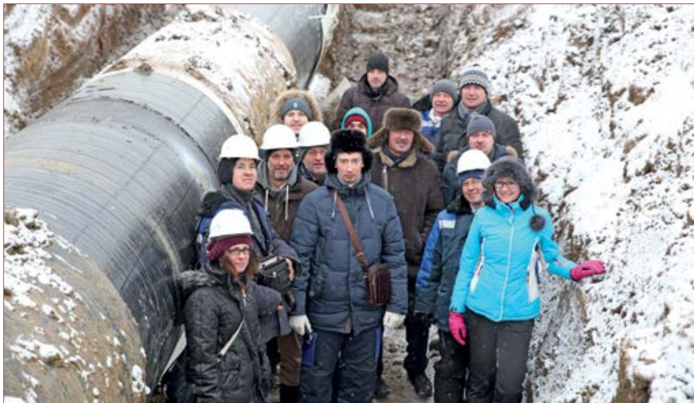
Рис. 3. Работа комиссии по вскрытию экспериментального участка в 2016 г.
