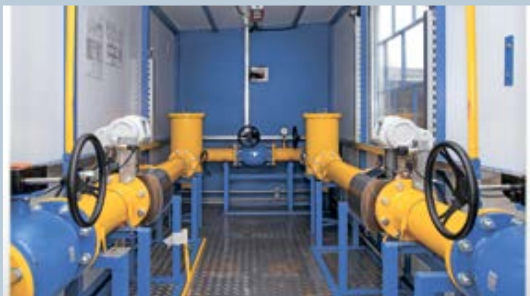
Рис. 2. Блочный пункт учета газа на базе расходомеров ультразвуковых серии Q.Sonic
