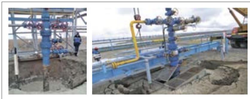
Рис. 1. Приустьевые воронки, образующиеся вследствие оттаивания ММГ
