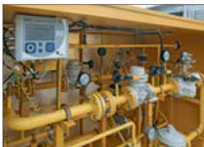
Рис. 3. Вариант применения корректора EK290 в составе двухниточного пункта учета и редуцирования газа
