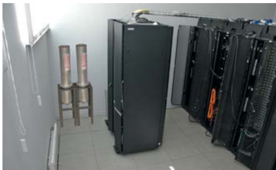
Рис. 4. Пример размещения АГАТ-2А в серверной
