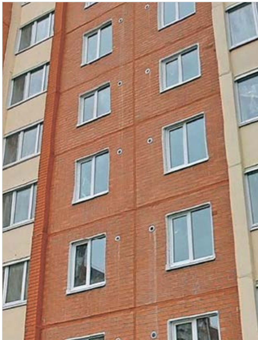
Фото 1. Санкт-Петербург. Многоквартирный дом, оборудованный стеновыми приточными клапанами
