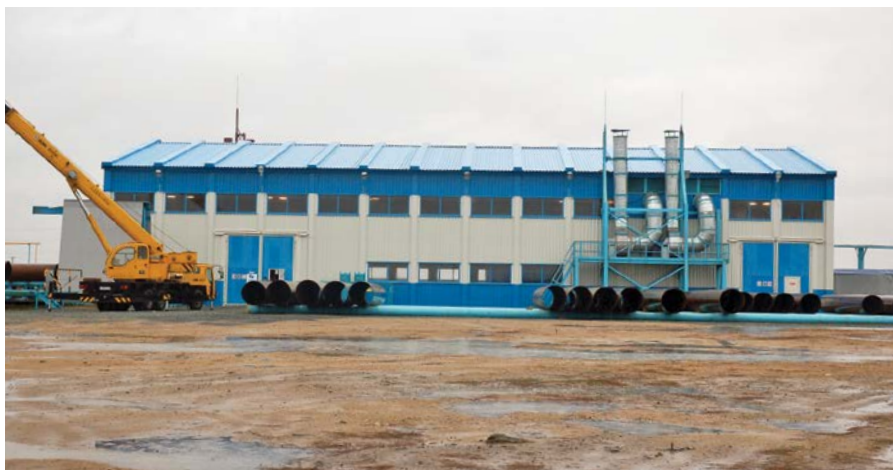
Фото 7. Мобильная база по ремонту изоляции труб (РИТ-М)
