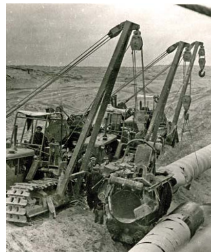
Фото 3. Начало строительства газопровода «Бухара – Урал»
