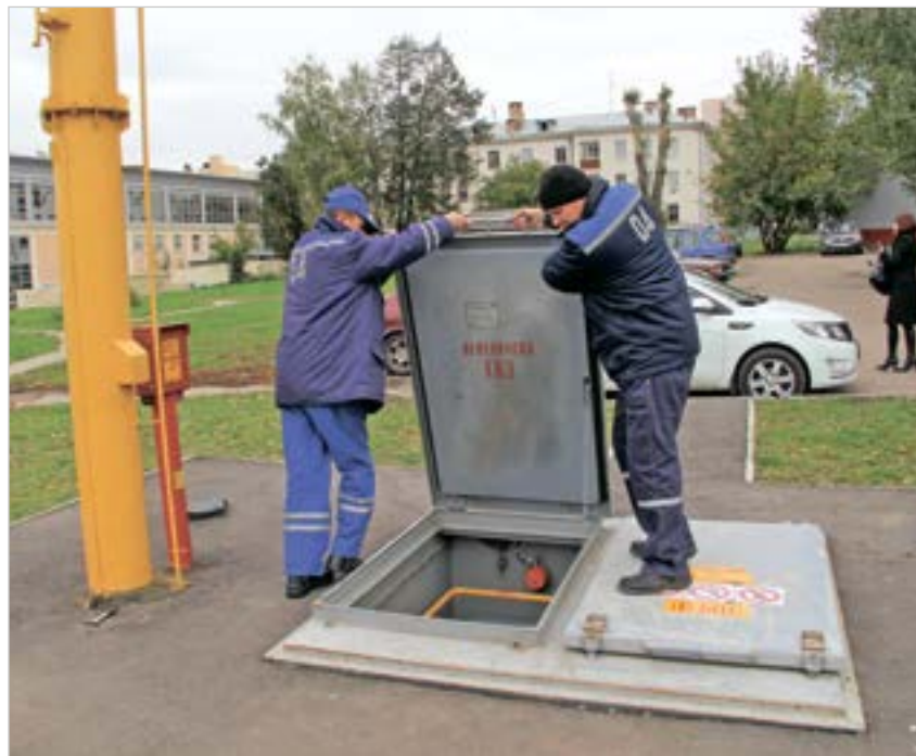
Фото 8. Крышку ПРГП можно поднять только вдвоем
