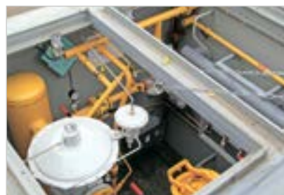
Фото 3. 21 июня 2012 г. Чебоксары, Президентский бульвар. Пункт редуцирования газа в подземном исполнении
