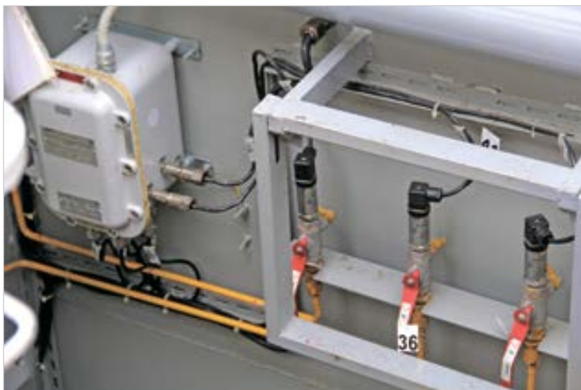
Фото 6. Блок телеметрии
