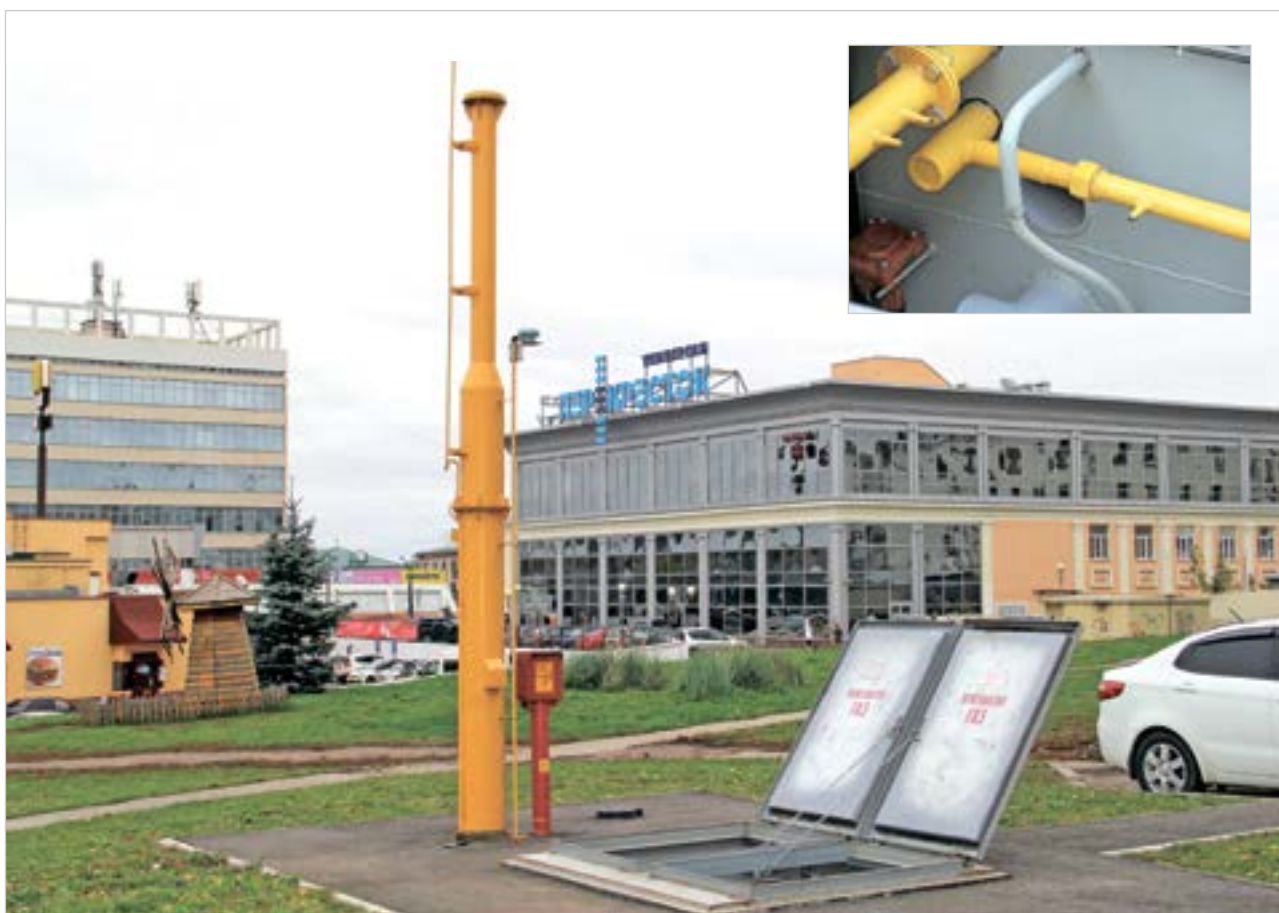
Фото 7. Продувочная мачта и узел ее присоединения
