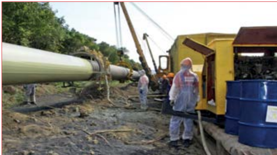
Рис. 4. Нанесение полиуретанового покрытия
