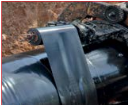
Рис. 3. Изоляция с применением материала рулонного мастичного армированного
