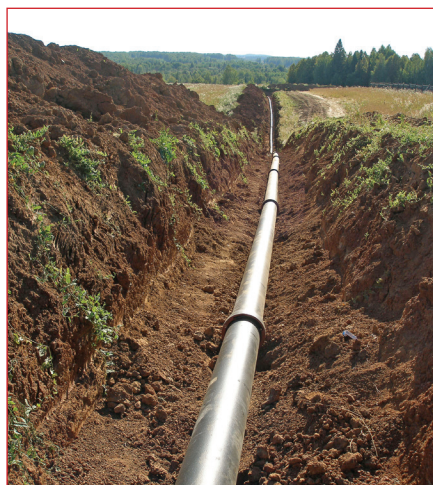
Рис. Трубопровод Ду 200 мм, из труб ВЧШГ с применением соединений типа RJ
