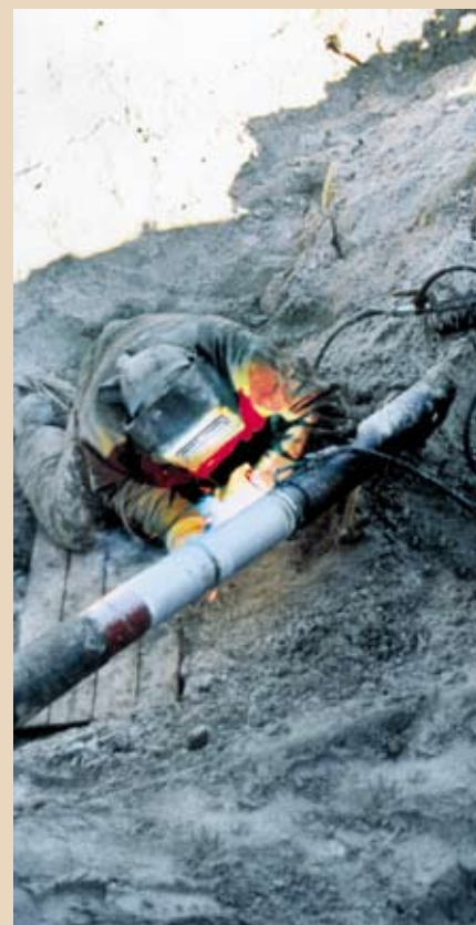
Рис. 2. Восстановление целостности внутреннего покрытия трубопровода после врезки в ОАО «Сланефть –Мегионнефтегаз»
