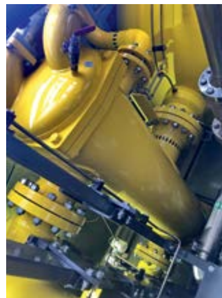
Фото 4. Элементы систем фильтрации и охлаждения газа: а) сепаратор 1-й ступени очистки; б) фильтр 2-й ступени; в) теплообменный аппарат
