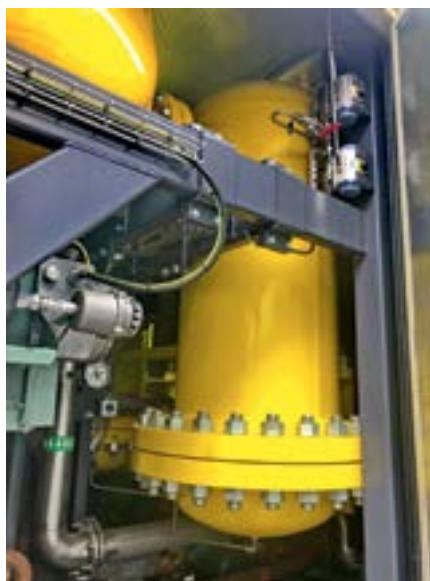
Фото 4. Элементы систем фильтрации и охлаждения газа: а) сепаратор 1-й ступени очистки; б) фильтр 2-й ступени; в) теплообменный аппарат
