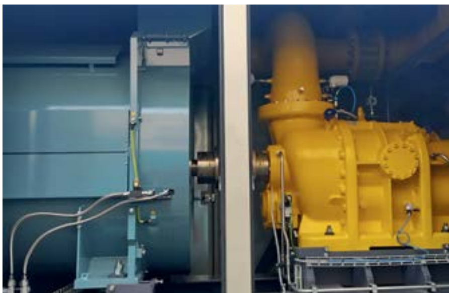
Фото 3. Основа ДКС-2 – винтовой компрессор с электродвигателем
