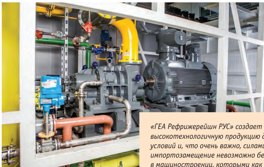
Фото 2. Дожимная компрессорная станция «ГЕА Сириус» на производстве в г. Климовске (Московская обл.)
