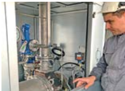
Фото 4. Собственные испытания оборудования завершают этап пусконаладочных работ
