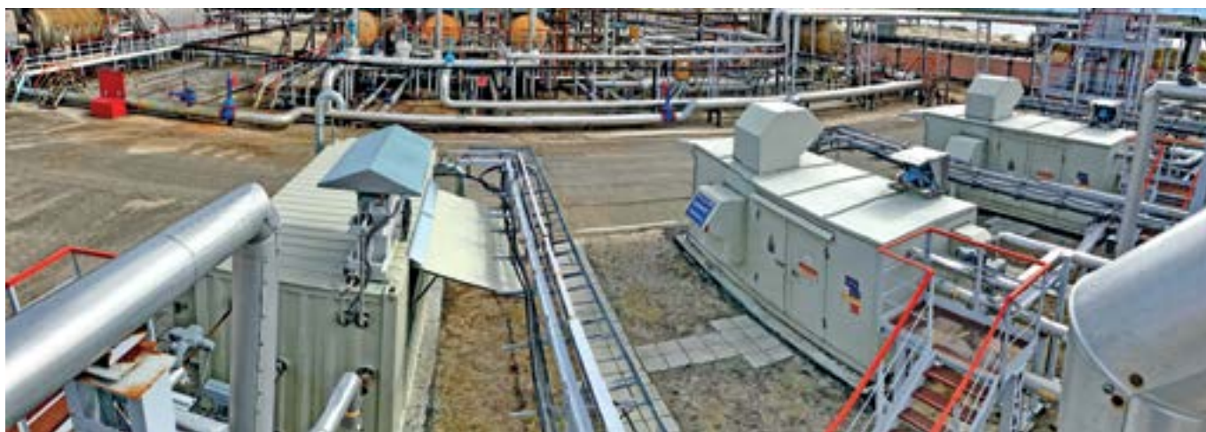
Фото 5. Конитлорское месторождение ПАО «Сургутнефтегаз». МГКУ «ЭНЕРГАЗ» (слева) на площадке дожимной насосной станции (ДНС) № 2 нефтегазодобывающего управления «Комсомольскнефть»
