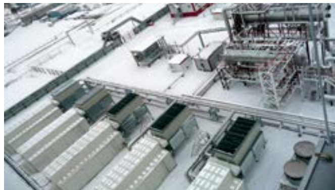
Фото 4. АLEXинское месторождение (ПАО «Сургутнефтегаз»). На компрессорную станцию низких ступеней сепарации поступает смешанный попутный нефтяной газ из нескольких источников
