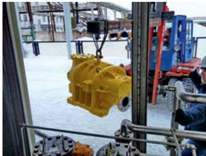
Фото 6. Монтаж компрессора, модернизированного с учетом новых условий эксплуатации
