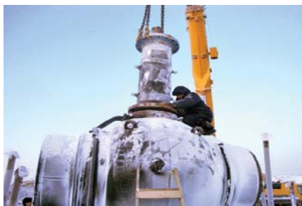
Фото 2. Предмонтажная подготовка и шефмонтаж ТПА на объекте
