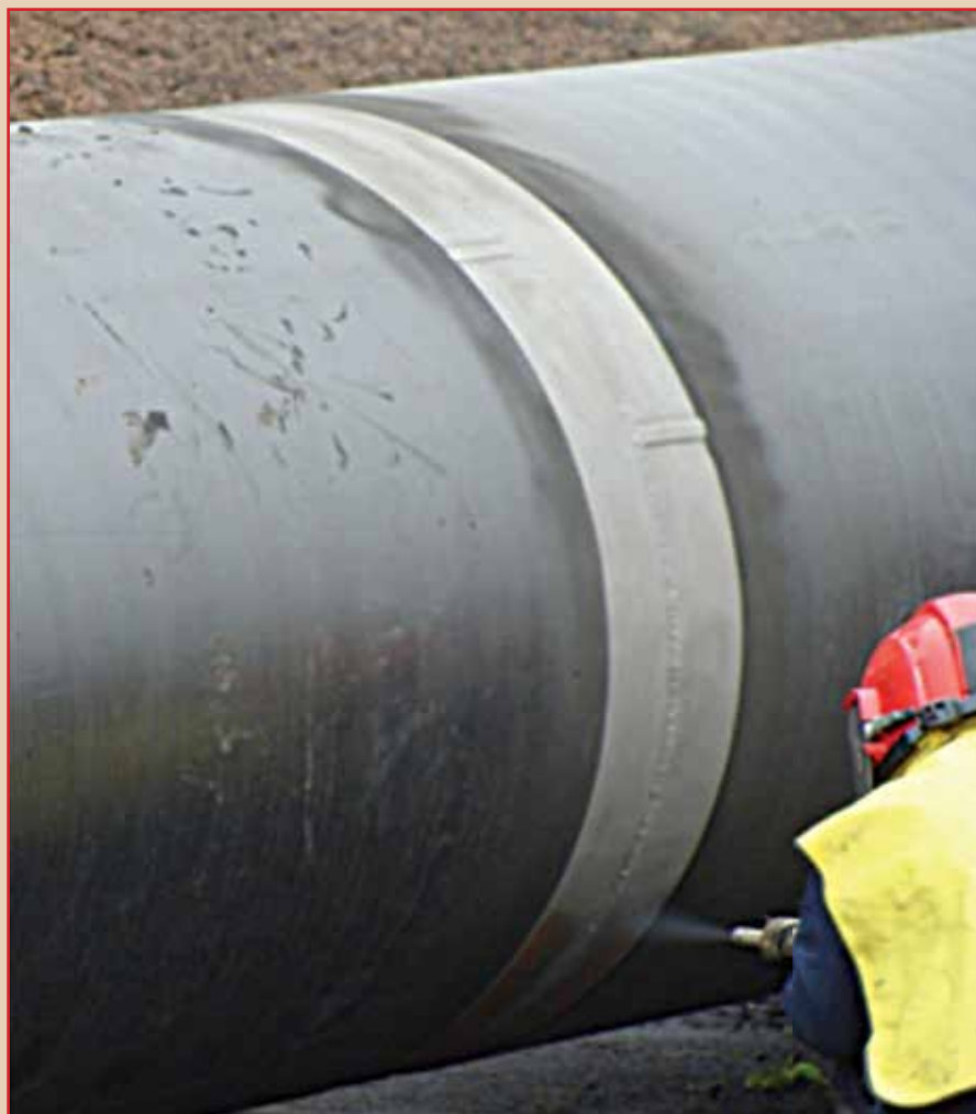
Абразивно-струйная обработка купрошлаком сварного стыка труб
