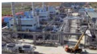
Реконструкция ДКС-6 Медвежьего НГКМ (2012 г.)
