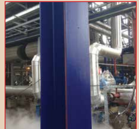
Рис. 5. Силотерм ЭП-6М RAL 5003, установка ГОБКК, МНПЗ
