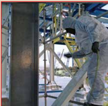
Рис. 4. Нанесение Силотерма ЭП-6М на колонны эстакад НГХК, ноябрь 2012 г., при t = -17\text{ }^{\circ}\text{C}
