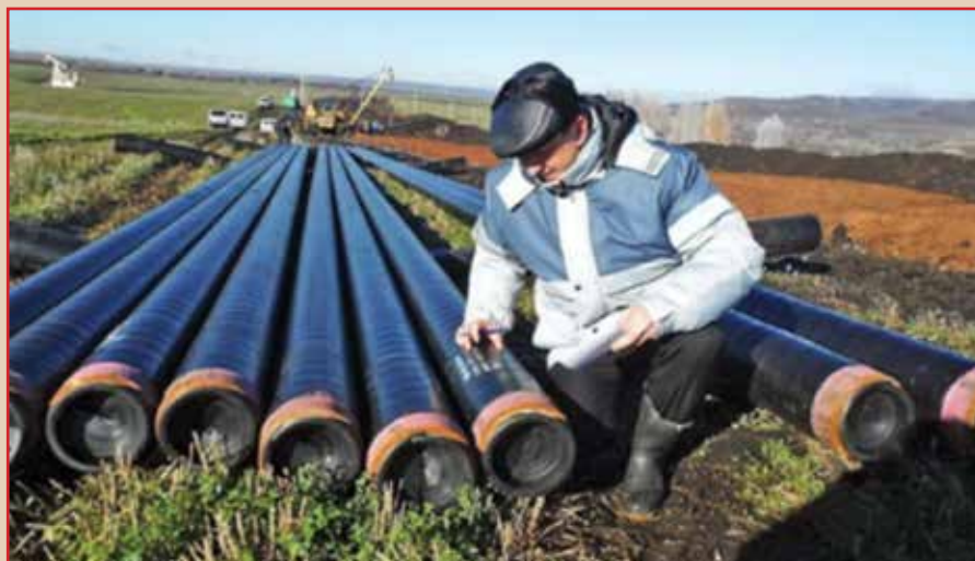
Рис. 5. Строительство трубопровода в коррозионно-стойком исполнении с использованием термоиндикаторных составов
