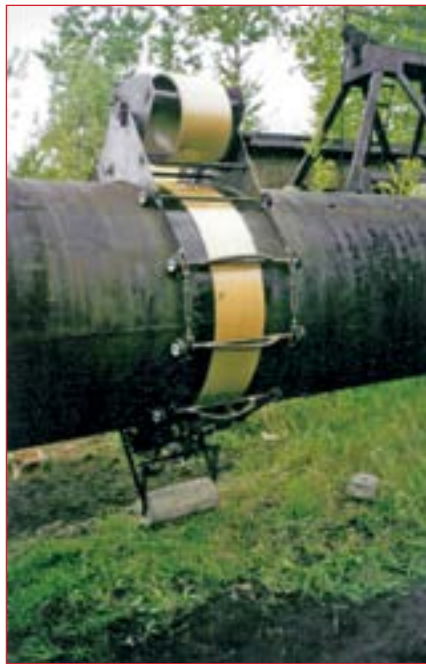
Рис. 1. Нанесение ремонтного материала с помощью намоточного устройства
