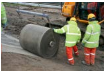
Рис. 2. Настилка материала СС (на снимке так называемый промышленный рулон, есть также бытовые компактные рулоны для работы без использования спецтехники)
