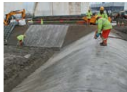
Рис. 3. Поливка водой для отвердевания бетонного полотна
