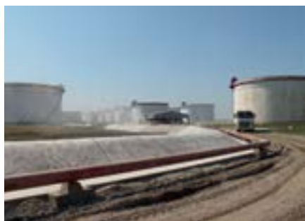
Рис. 1. Бетонированное полотном СС каре резервуарного парка
