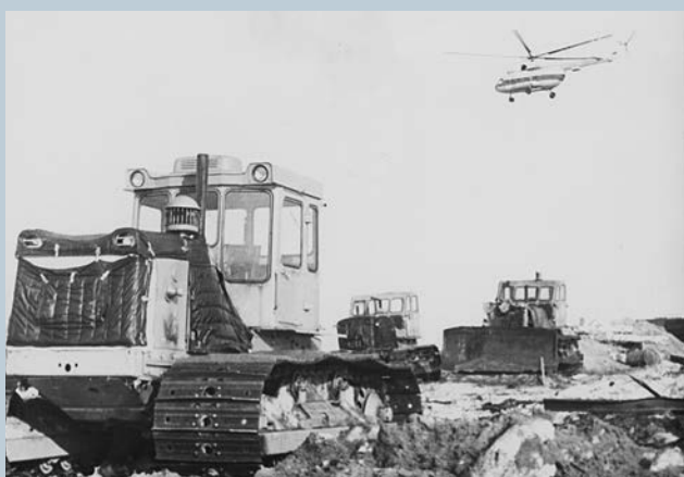
Строительство газопровода «Новосибирск – Барнаул», 1984 г.
