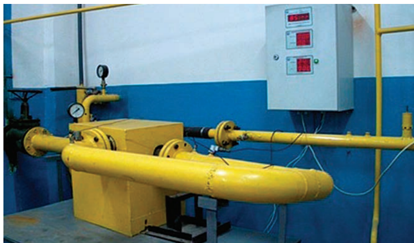
Фото 3. Турбонагреватель, преобразующий потенциальную энергию избыточного давления газа
