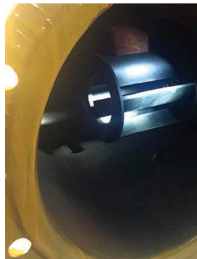
Фото 5. Поточковая турбина выдвинута микролифтом в трубопровод
