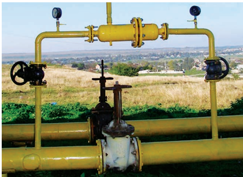
Фото 1. Турбодетандер электропитания 2 кВт (Кабардино-Балкария)
