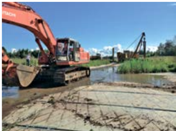
Рис. 5. Применение временных дорожных конструкций Fig. 5. Application of temporary road constructions
