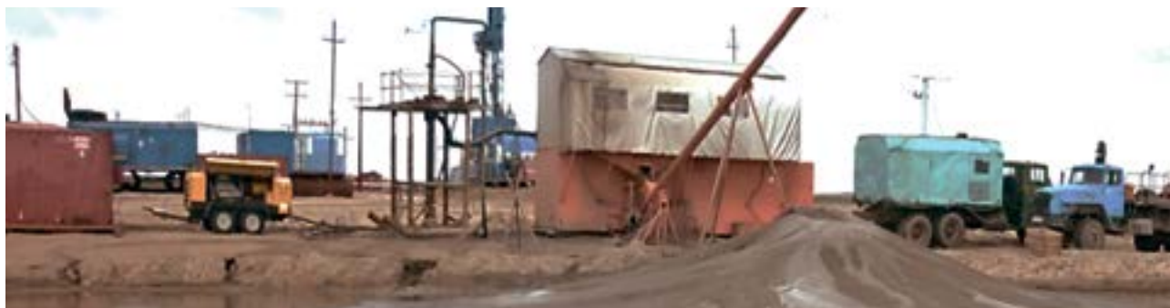
Рис. 3. Комплекс по строительству подземного резервуара Fig. 3. Complex for the construction of the underground storage
