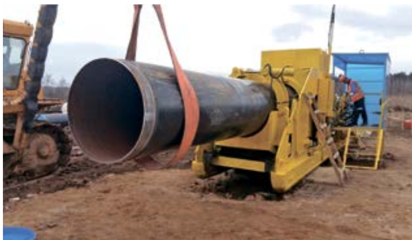
Рис. 1. Изготовление отвода холодного гнутья в трассовых условиях Fig. 1. Production of cold bend in the route conditions
