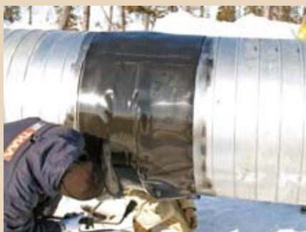
Рис. 4 Гидроизоляция теплоизоляционного слоя
