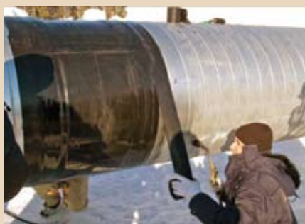
Рис.5 Нанесение адгезивных лент ТИАЛ-З
