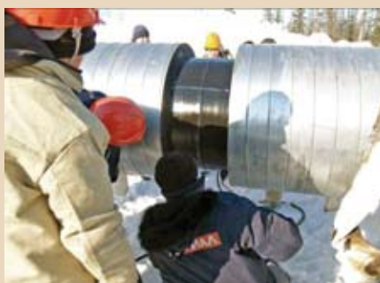
Рис. 3 Нанесение антикоррозионной манжеты ТИАЛ-М80
