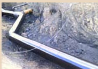
Фото 6. Трассовая изоляция КС ООО «Томсктрансгаз», Чажемто, 2006. Технология ООО «Газпромэнергодиагностика». Покрытие Protegol UR-Coating 32-55H
