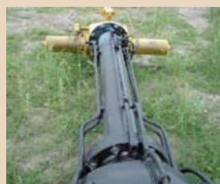
Фото 5. Базовая изоляция ООО «Волготрансгаз», Помары, 2006. Покрытие Protegol UR-Coating 32-55H
