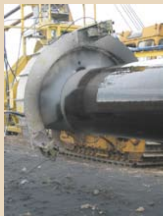
Фото 2. Трассовая изоляция газопровода Бухара-Урал ООО «Уралтрансгаз», 2004. Покрытие Protegol UR-Coating 32-55R. Технология Incal Pipeline Rehabilitation
