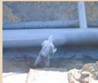
Фото 7. Трассовая изоляция ЦДКС ООО «Тюментрансгаз», Пангоды, 2005. Покрытие Protegol EP-Coating 130HT
