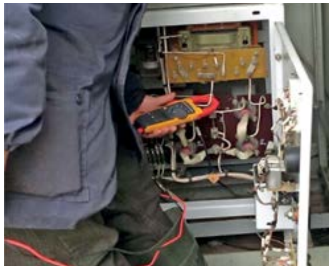
Рис. 3. Проведение измерений выходных параметров станции катодной защиты
