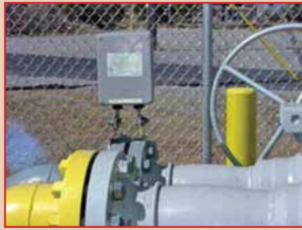
Рис. 2. Установка заменителя поляризационной ячейки на электроизолирующем соединении трубопровода
