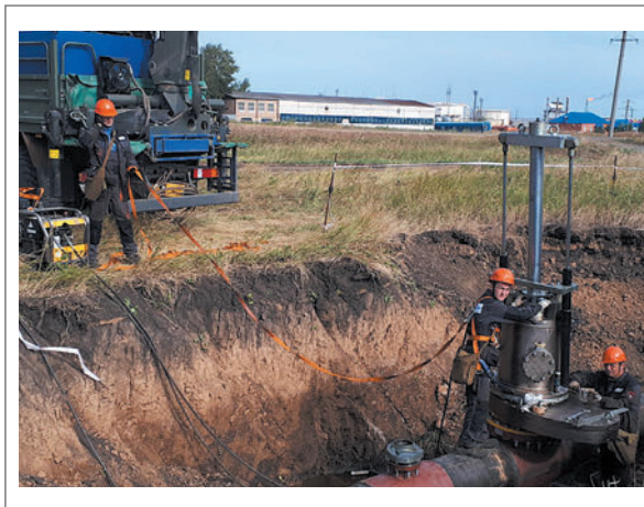
Рис. 2. Перекрытие нефтепровода Ду 500 мм давлением 40 кгс/см 2
