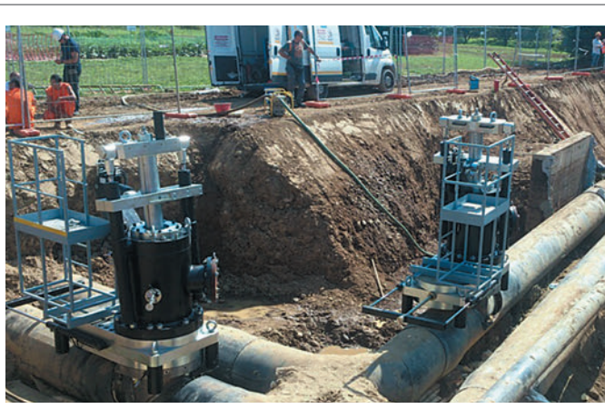
Рис. 3. Перекрытие трубопровода Ду 600 мм давлением 24 кгс/см 2
