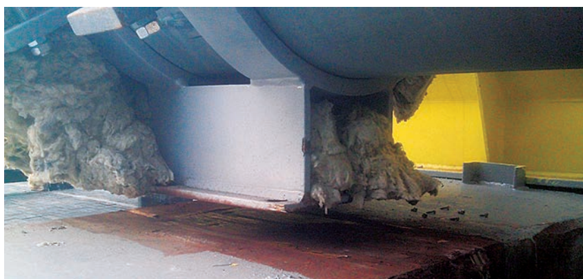
Рис. 8. Подъемы участков коллектора газа между опорами РВ-14 и РВ-17
