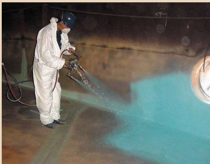
Нанесение системы Matcote®
