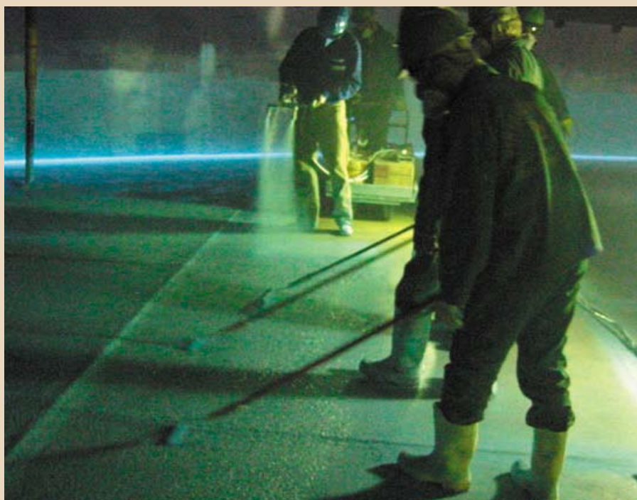
Прикатывание покрытия валиком
