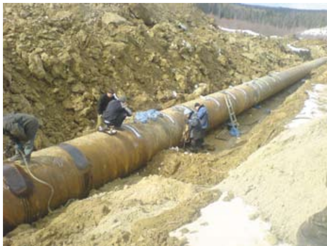
Рис. 2. Установка датчиков скорости трещины, давления газа и температуры трубы
