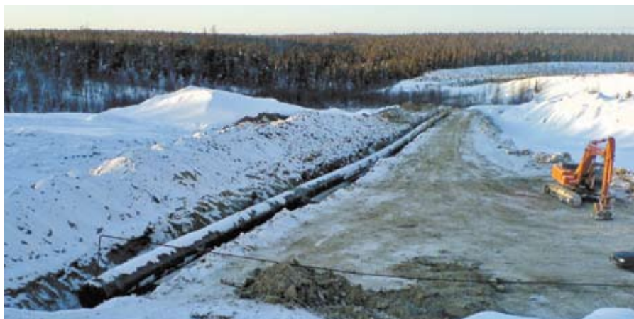
Рис. 1. Опытная плеть, сваренная на временном полигоне ООО «Севергазпром»
